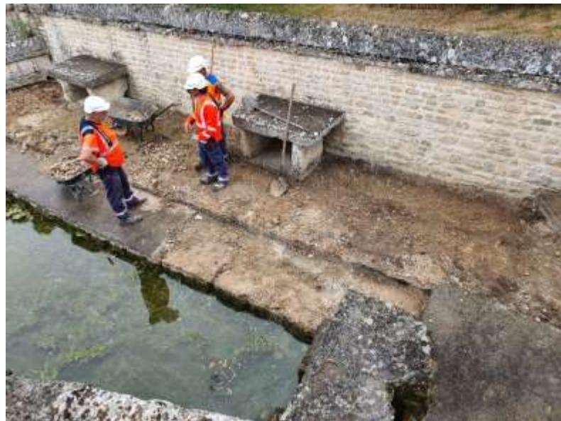
Le démarrage du curetage laisse apparaître de gros moellons en première périphérie de bassin...à priori pavage de qualité avec quelques fissures à combler (joint chaux sable fin) Une seconde ligne de moellons apparaît le long du mur avec une marche...état général à voir après nettoyage.
