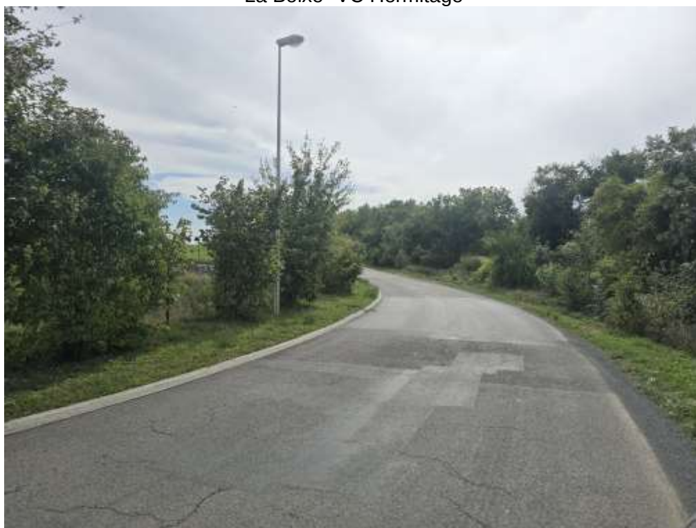
VC Breger communautaire – courbe réparée à l'enrobé
