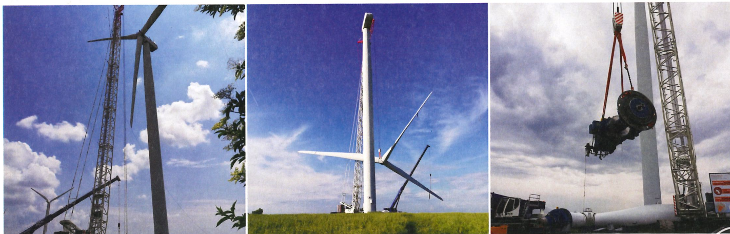
Parc éolien ABO Wind - Xambes-Vervant (16) - Remplacement du palier principal de l'éolienne 3 (mai 2018)
