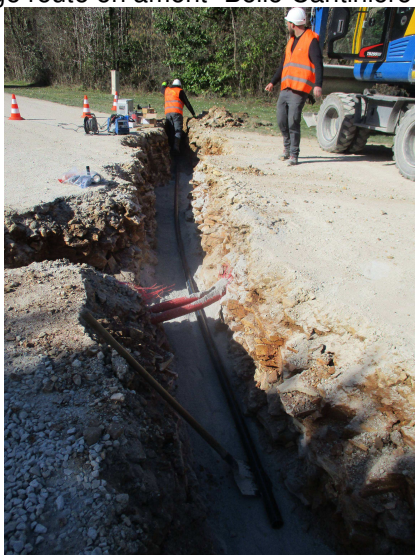
Canalisation sous VC103 en cours
