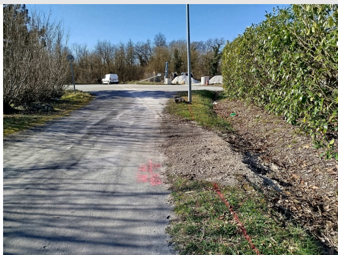
Sondage route en amont "Belle Cantinière" réalisé
