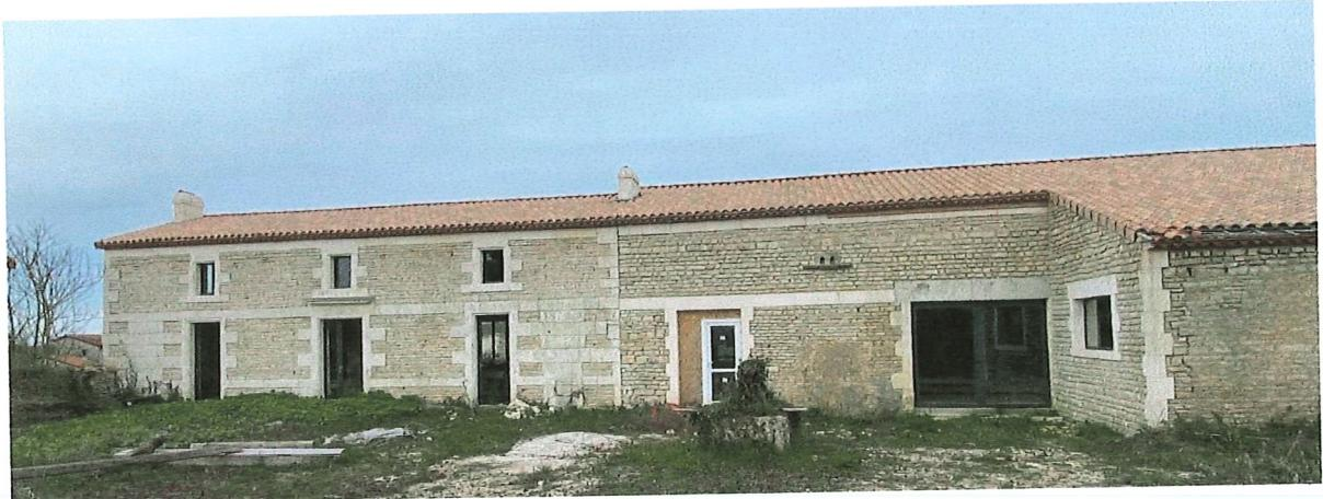
*La couverture du toit a été refaite intégralement en tuiles romane canal vieilli, ton castel. La toiture en deux versants a été conservé, tel qu'à l'origine.*
