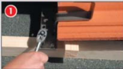
installer les crochets
