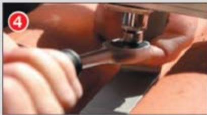
Fixer les profils Solar-Plus sur le crochet
