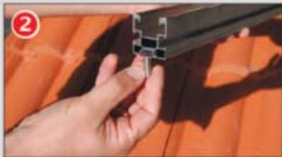
Insérer les vis dans les profils Solar-Plus
