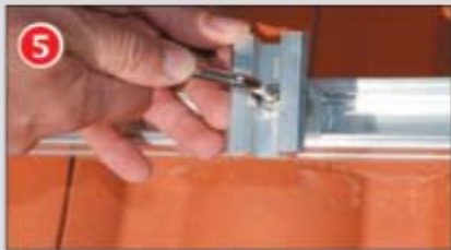
Insérer les brides PMF et PMC
