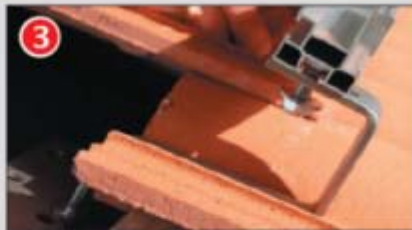
Positionner le profilé Solar-Plus sur le crochet
