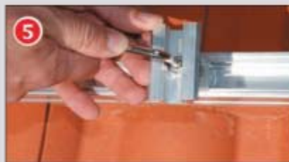
Insérer les brides PMF et PMC
