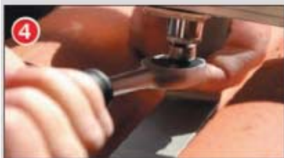
Fixer les profilés Solar-Plus sur le crochet
