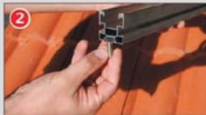
Insérer les vis dans les profilés Solar-Plus
