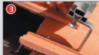
Positionner le profilé Solar-Plus sur le crochet
