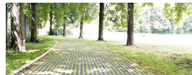
Revêtement de circulation douce semi-perméable
