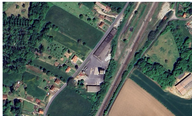
Entreprise OCEALIA, rue des Chenevières du Puits à Luxé
