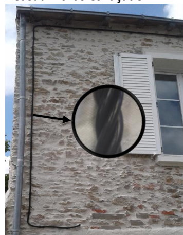
Réseau fils isolés façade BT
