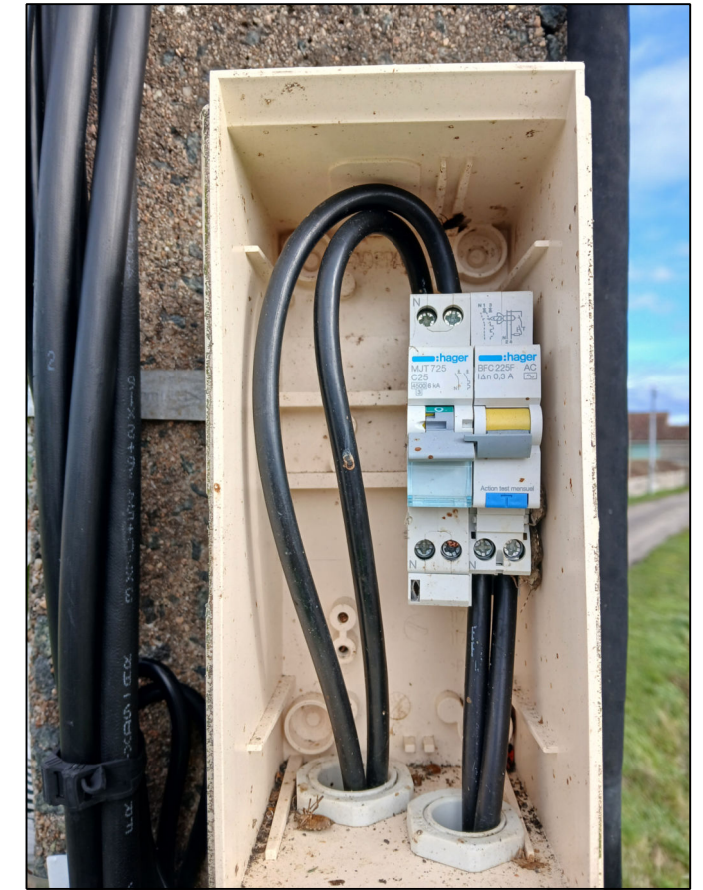
Remplacement du disjoncteur existant par un disjoncteur différentiel haute sensibilité 25A-300mA - courbe B
