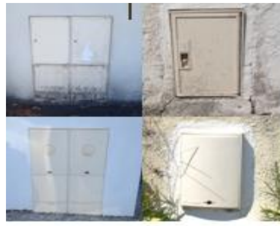
Coffret de raccordement individuel (S20) sans compteur
