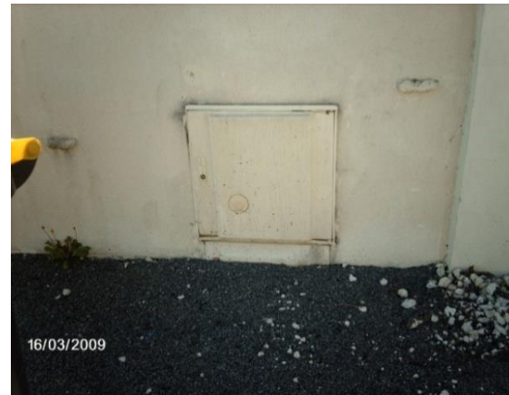
Coffret de raccordement individuel (S300) avec compteur
