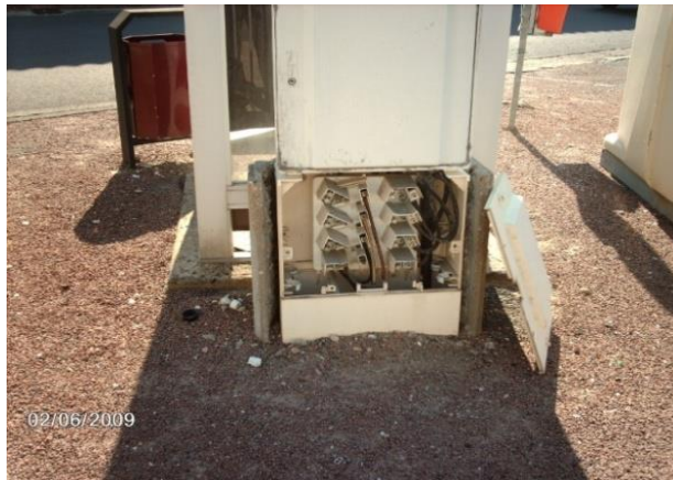
Coffret de réseau fausse coupure avec coffret de raccordement
