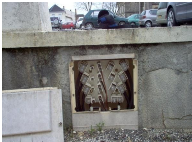
Coffret de réseau fausse coupure
