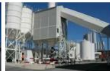
192 centrales de béton prêt à l'emploi
