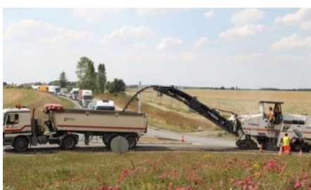
Rabotage de chaussée
