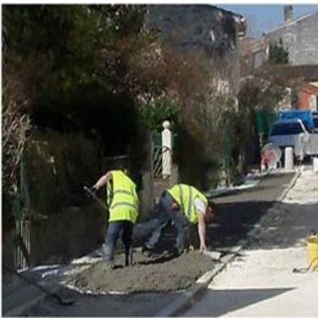
Mise en œuvre du béton
