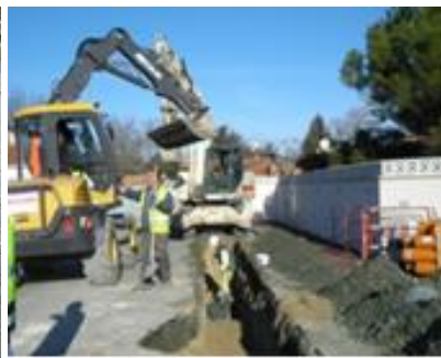
Remblaiement de tranchée
