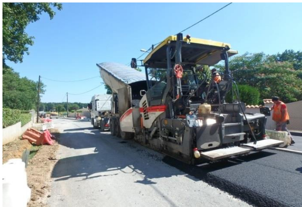
Atelier de mise en œuvre d'enrobé
