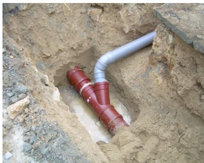
Branchement sur canalisation existante
