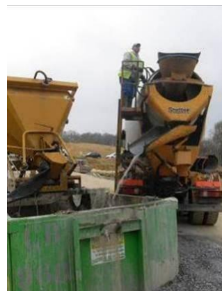
Exemple d'utilisation de bennes pour le recueil des laitances lors du nettoyage des goulottes de toupies à béton
