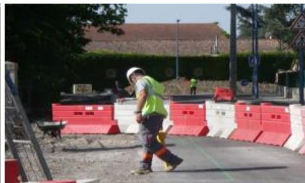
Repérage de réseaux existants avant sciage
