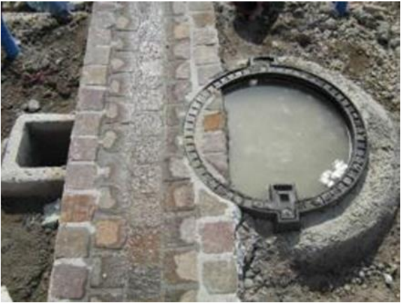
Remplissage des émergences
