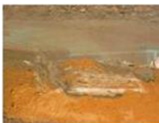
Dépôt de laitance sur point bas
