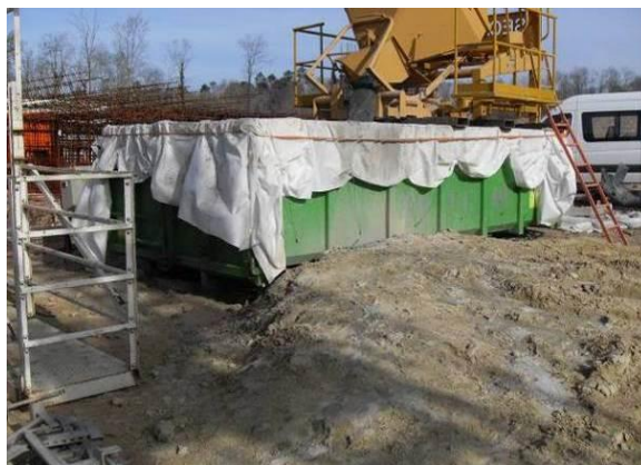
Exemple d'utilisation de bennes pour le recueil des laitances lors du nettoyage des goulottes de toupies à béton
