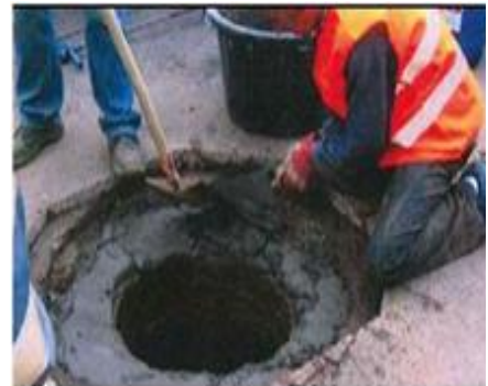
Mise à la cote et scellement
