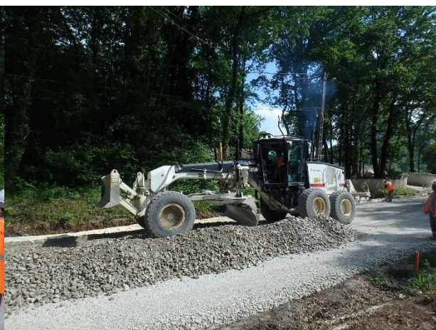
Réglage de la GNT à la niveleuse
