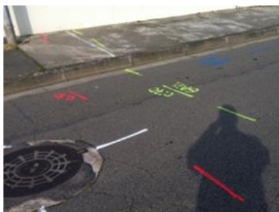
Repérage des réseaux existants
