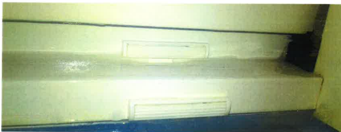
Busettes à clapet au niveau de l'ouvrant de service
