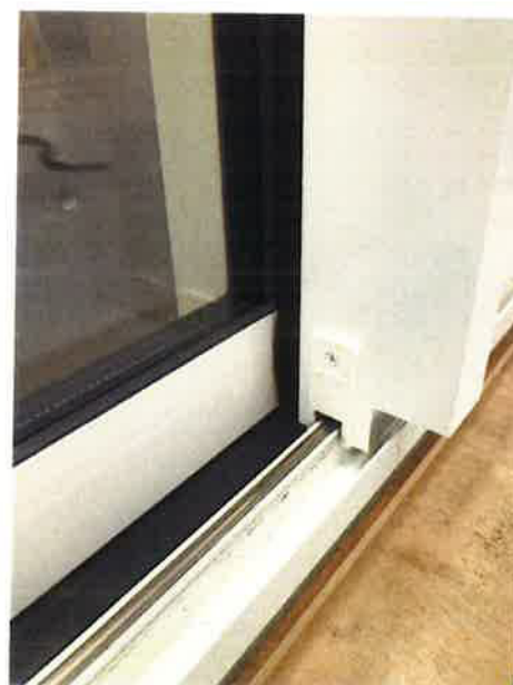
Traces noire sur la traverse de l'ouvrant
