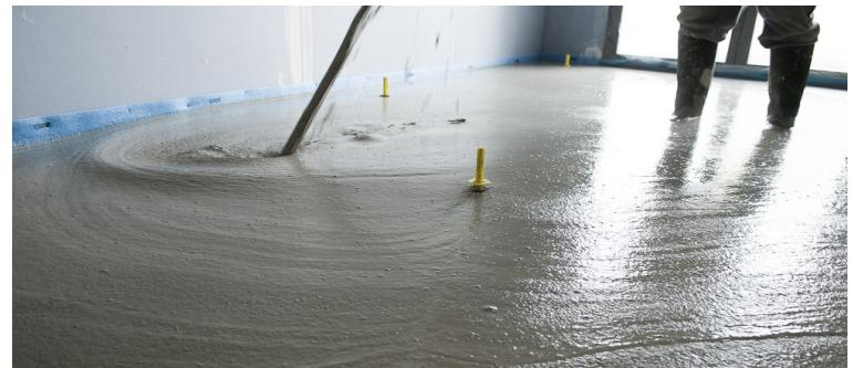
**Agilia CHAPE NIVEL** est une gamme de chapes fluides à base de ciment ou d'anhydrite. Elle permet de rattraper la planéité et/ou l'horizontalité des sols avant la pose du revêtement.
