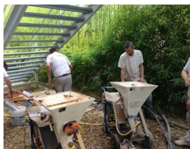
Machine utilisée pour l'application mécanique du ragréage.
