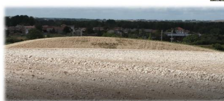
Remblais au niveau de l'AEI lors des travaux de la LGV et Villognon en arrière (source : propriétaire du site)
